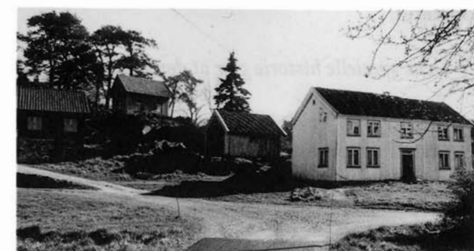
Tunet på Timenes, bygninger med høy alder
