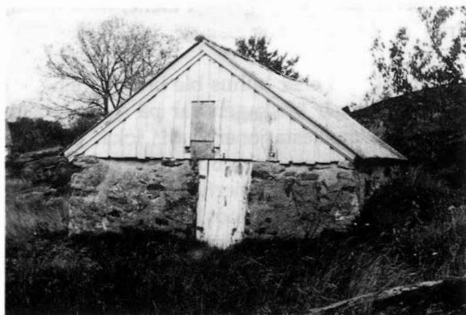
Jordkjeller, Medbøe, Flekkerøy
