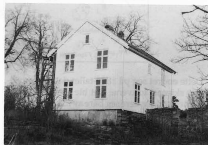
Thaulows hus restaureres av Kristiansand Byselskap
