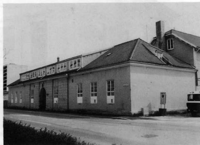
Ekserserhuset - fredet i 1984
