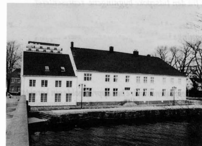
Gravane, et eksempel på et lite miljø som er bevaringsverdig
