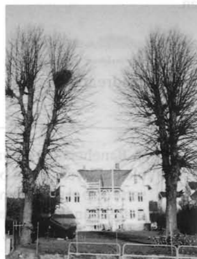
Materialstykket 5 under rehabilitering
