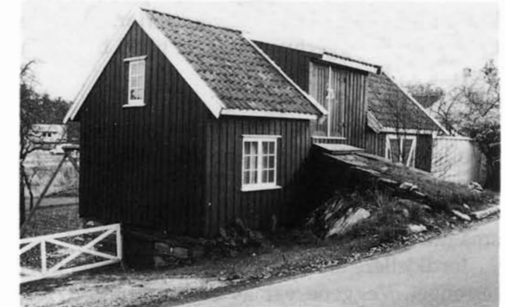
Liten driftsbygning, Møvig, Vågsbygd
