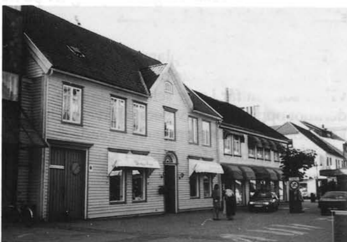
...og større eldre trehus
