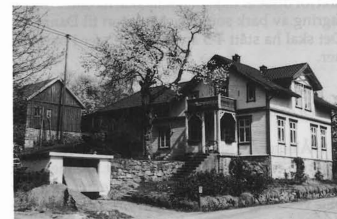
Ålefjær 120/98 , oppført som skysstasjon
