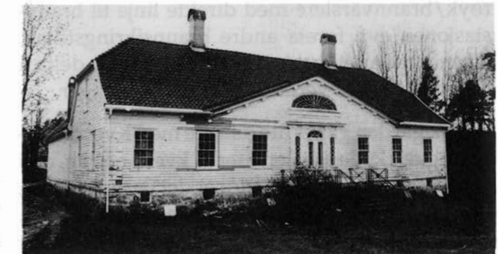
Hovedbygningen på Andøya Gård under restaurering
