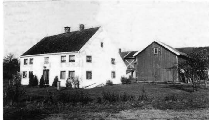
Midtgangshus i to etasje, med skjev røsting Bøen, Kjevik.
