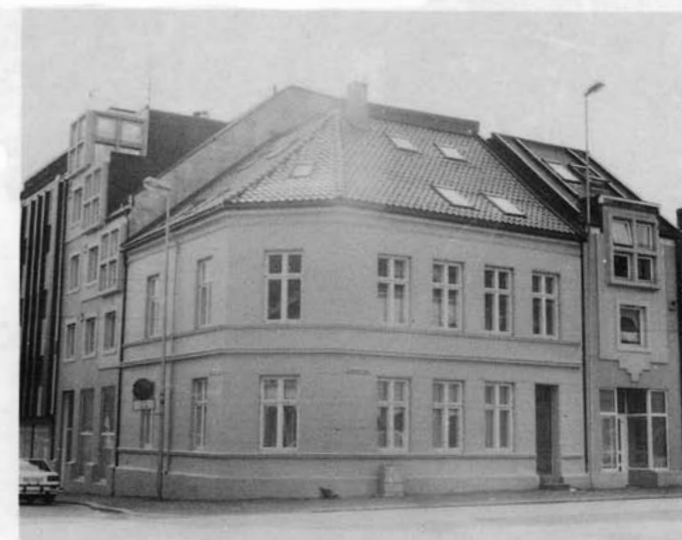
Eldre murhus i Dronningensgate med tilpasset nybygg
